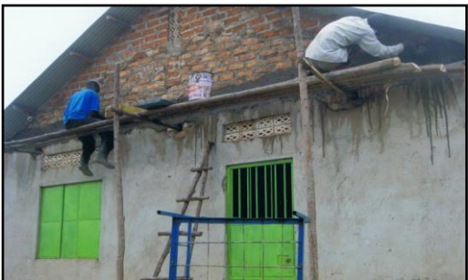
Reparation af pigernes sovesal
