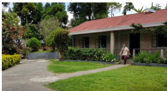
Kun de store drenges hus er i brug
